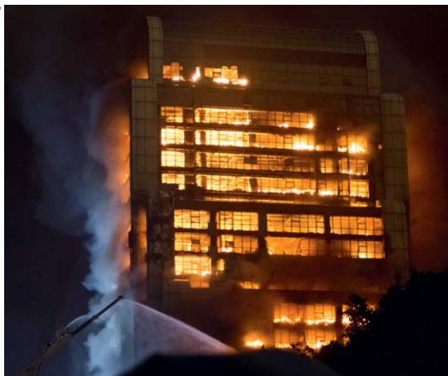
Bild 1 Die Wahl des richtigen Kabels kann helfen, die Ausbreitung des Feuers zu reduzieren und somit Menschenleben und Sachwerte zu schützen.
