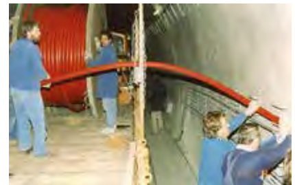
Kabelverlegung und Montage bei der U-Bahn und S-Bahn in München
