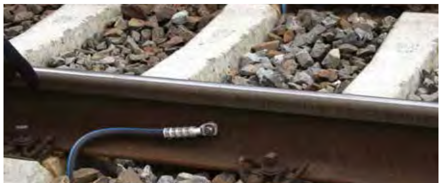
Bayka-Aluminium-Bahnerdungsleitung
