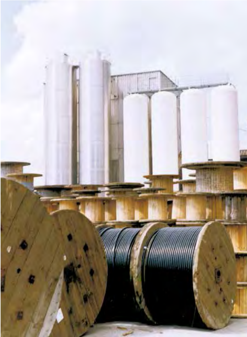
Werksgelände mit Kunststoffsilos
