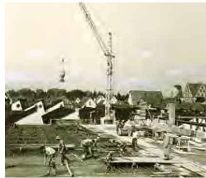
Neubau der Einzeladerabteilung
